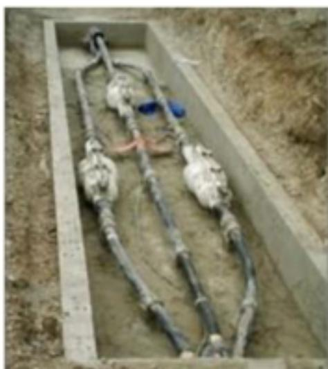
Figure 11 : Exemple d'une chambre de jonction
