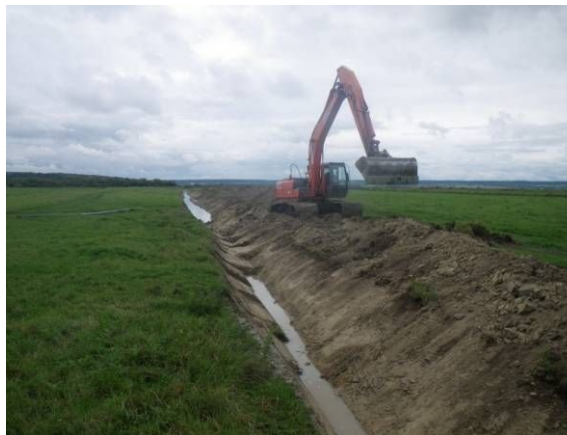
Prolongation et remise au gabarit d'un fossé
