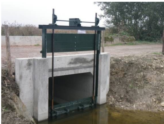
2 ouvrages hydrauliques créés, 1 réhabilité
