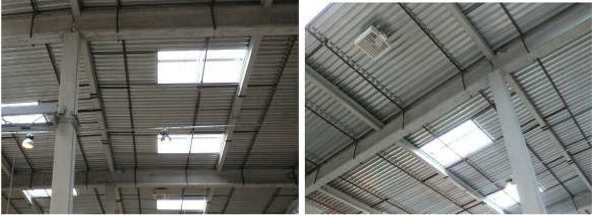
Figure 8 : Dispositifs d'évacuation naturelle des fumées et des chaleurs (DENFC)
