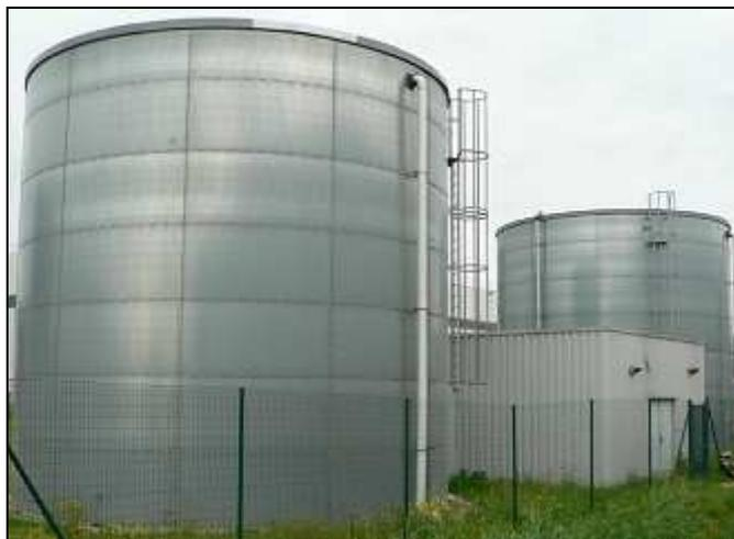
Figure 10 : Local et cuves de sprinklage
