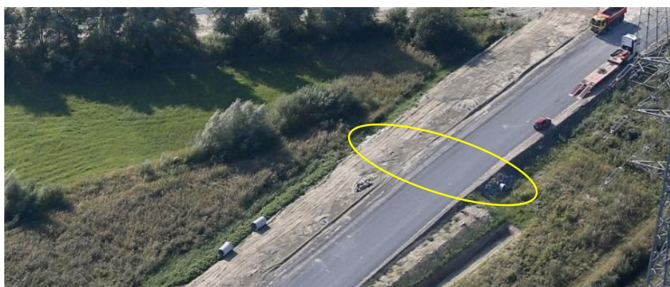
Figure 42 : Vue aérienne du passage à faune (GPMH, 2016)
