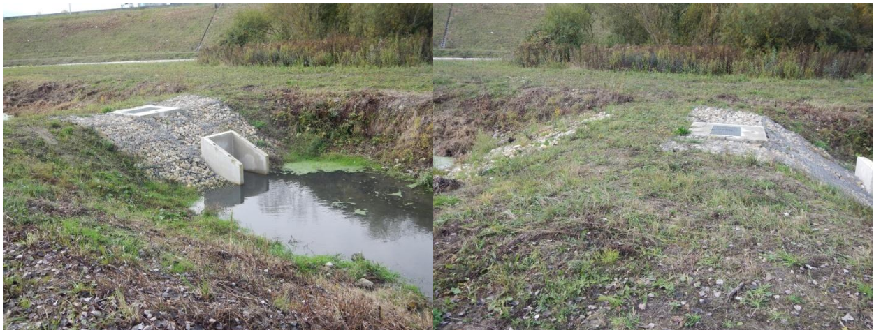
Figure 27 : Ouvrage de fuite permettant une régulation de l'eau en amont (GPMH, 2016)
