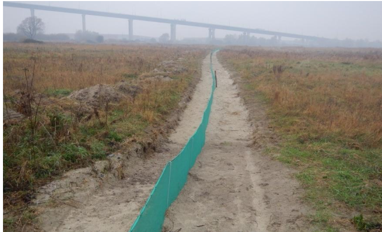
Figure 38 : Mise en place de la mesure RED 6 Mise en place de barrières anti-amphibiens au Sud du chantier PLPN 2 (GPMH, 2016)
