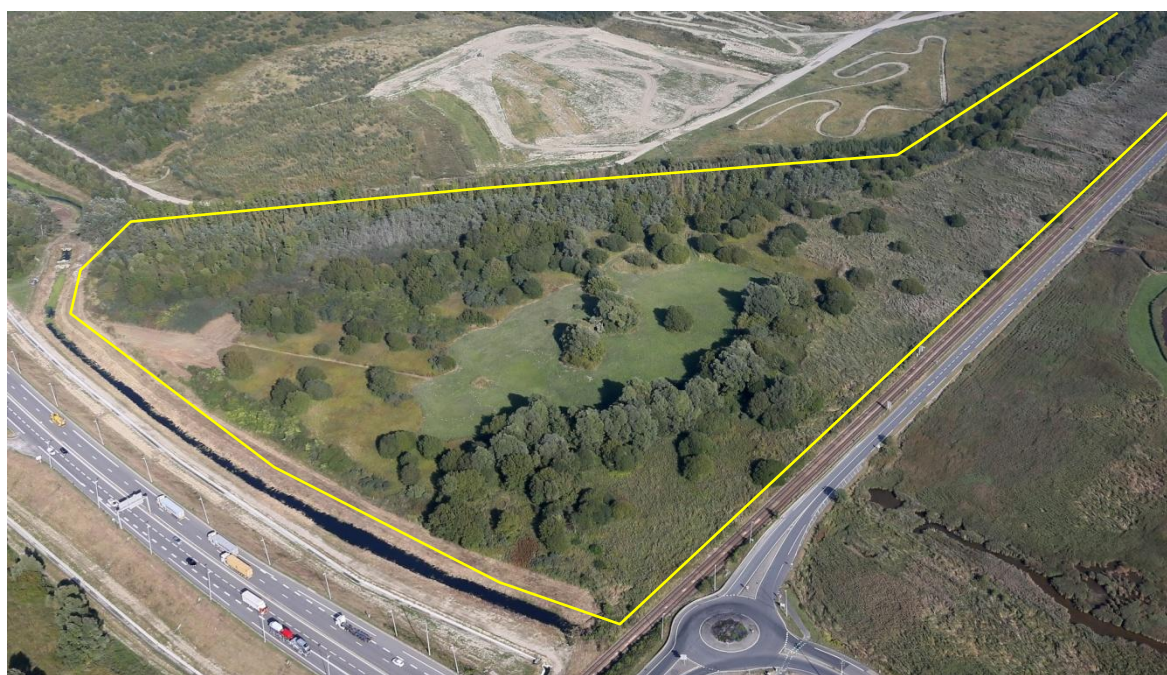
Figure 33 : Vue aérienne de la mesure M23-Ouest en octobre 2016 (GPMH, 2016)
