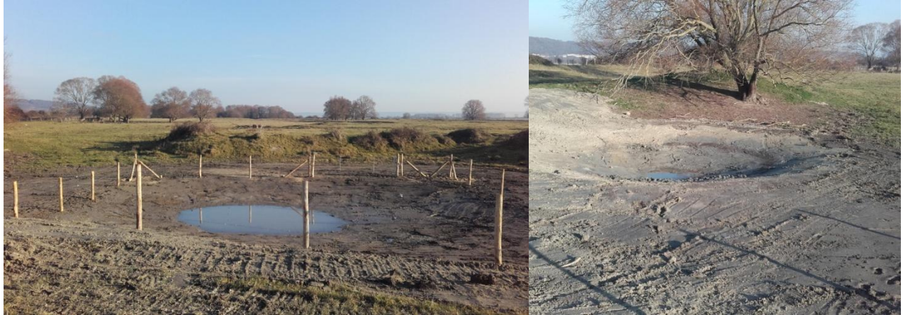
Figure 36 : Curage et mise en défens de la mare à gauche, création d'une mare abreuvoir pour le bétail à droite (GPMH, 2016)
