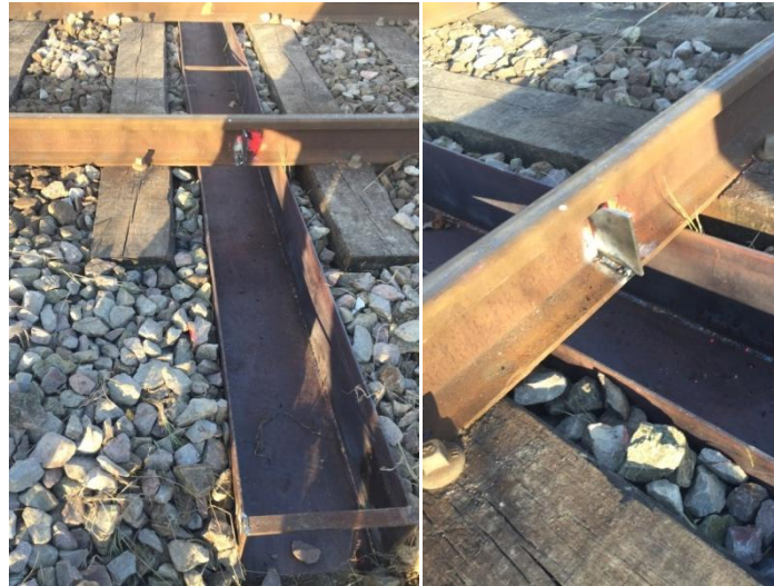
Figure 46 : Passage à faune sous voie ferrée (GPMH, 2016)
