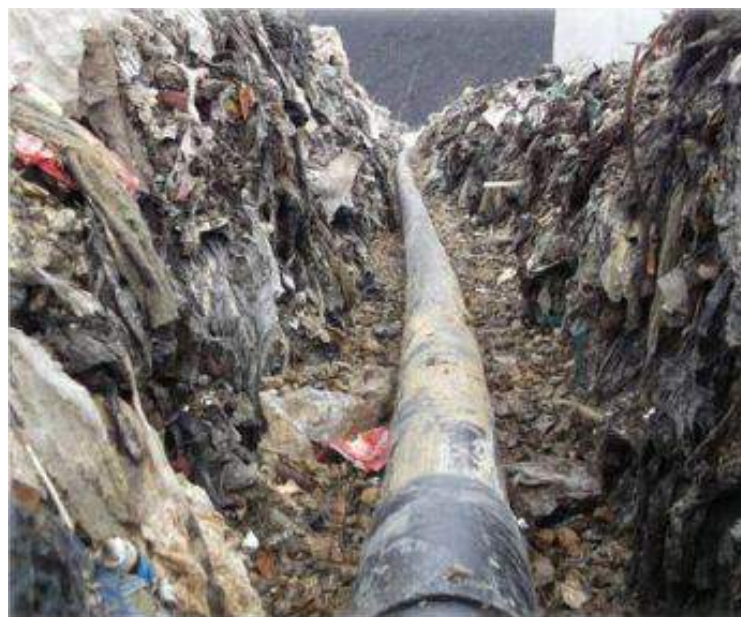
Figure 81 : Drain horizontal de captage du biogaz
