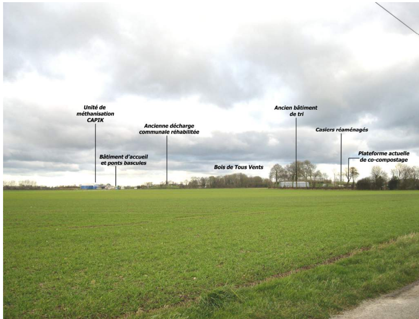
Figure 23 : Photo n°3 – Vision du CVD depuis les habitations et exploitations agricoles au lieu-dit « les fosses » – Perception partielle du CVD partiellement occultée par les bosquets à l’Est – Vision de l’unité de méthanisation CAPIK et de l’ancien bâtiment de tri
