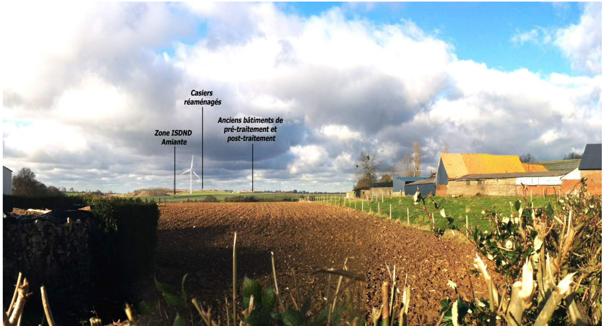
Figure 24 : Photo n°4 – Vision du CVD depuis les habitations de Saint-Pierre-des-Jonquières (Route Départementale RD59) - Perception du site partielle atténuée par la topographie et la présence de bosquets
