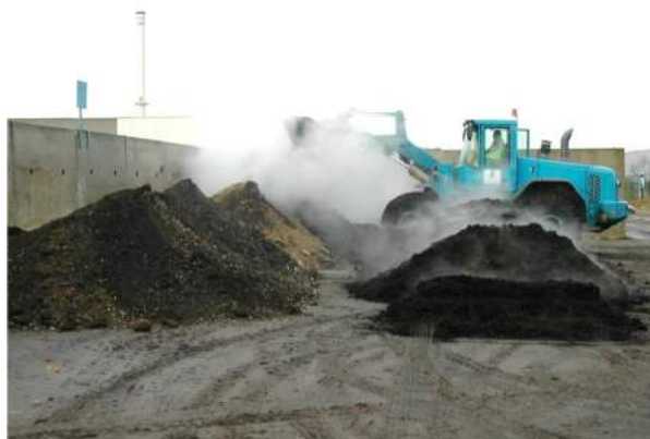
Figure 52 : Mélange du compost avec les terres hydrocarbonées
