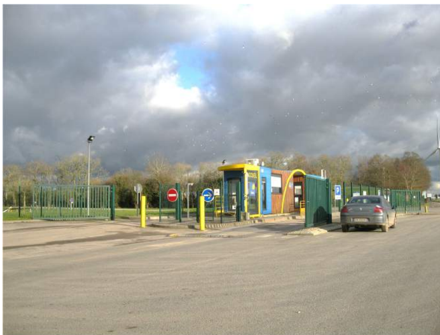
Figure 17 : Bâtiment d'accueil et de réception du CVD
