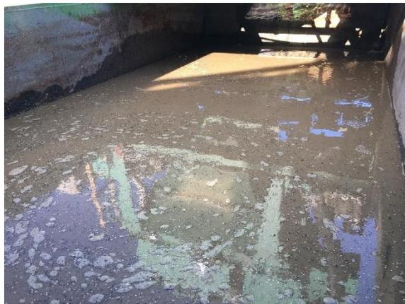
*Figure 11 : Aperçu des microfragments de plastique en flottaison sur le bac de récupération des boues (fraction < 0,063  $\mu\text{m}$ )*
