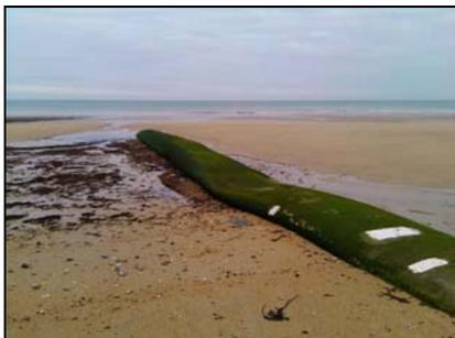
**Figure 3 : Epi en géotextile**
