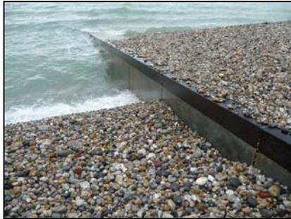
**Figure 2 : Epi en rideau de palplanches auto-stable et couronnement béton/bois**
