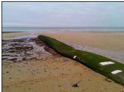
Figure 4. Epi en géotextile
